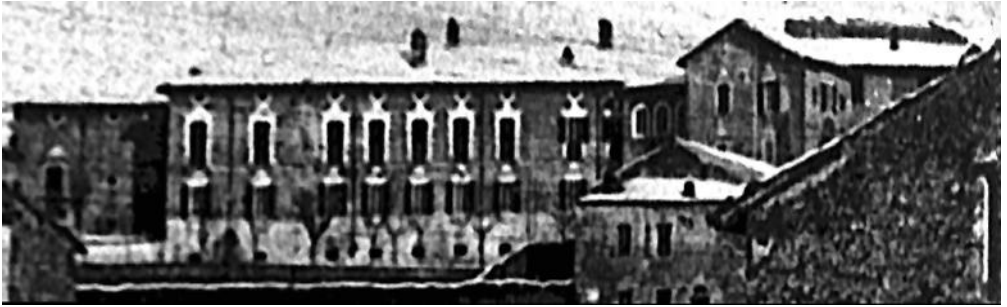
Palazzo Ferrante prima del terremoto del 1915
